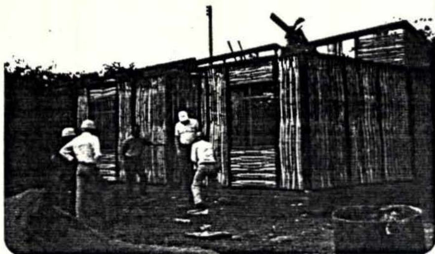
9. Construcción de cubierta
