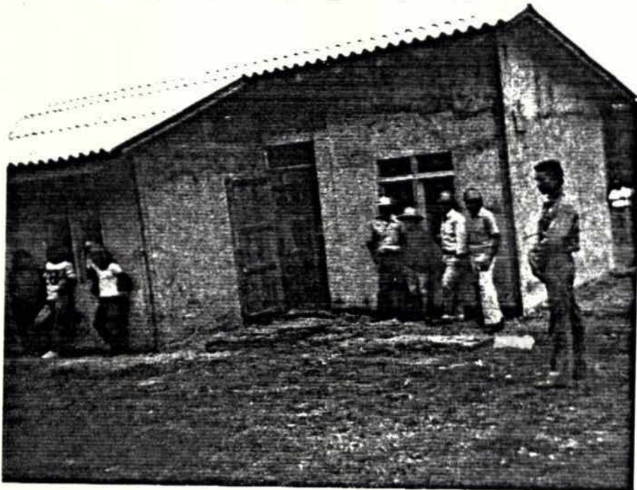
16-B Mortero fino, puertas y ventanas
