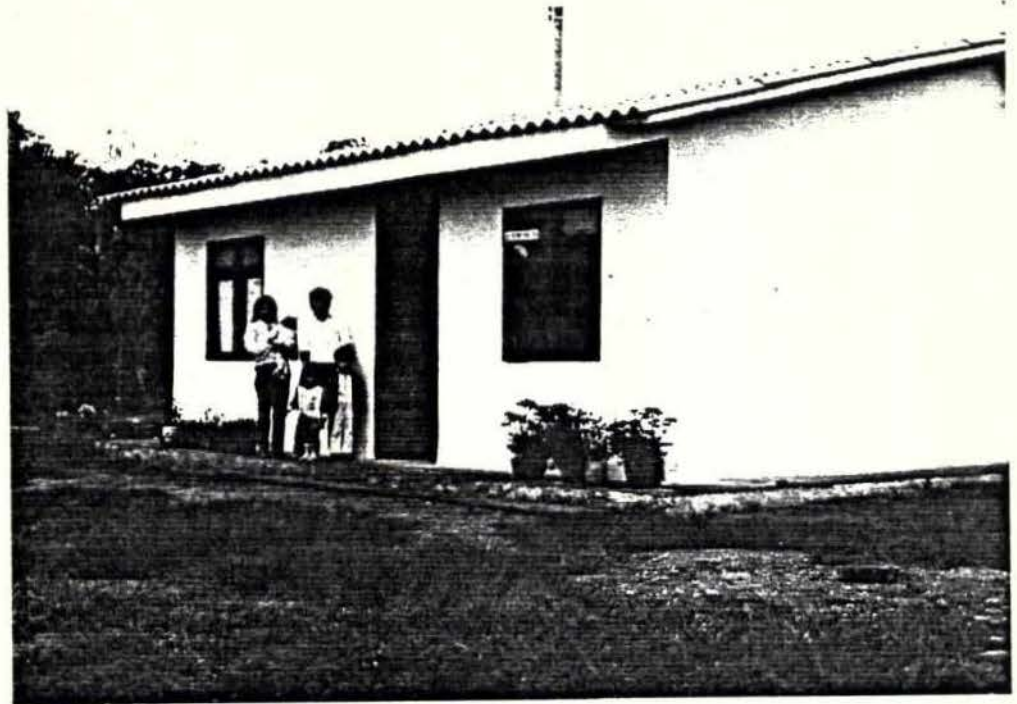
17. Casa de Bahareque Modular (Quincha) terminada
