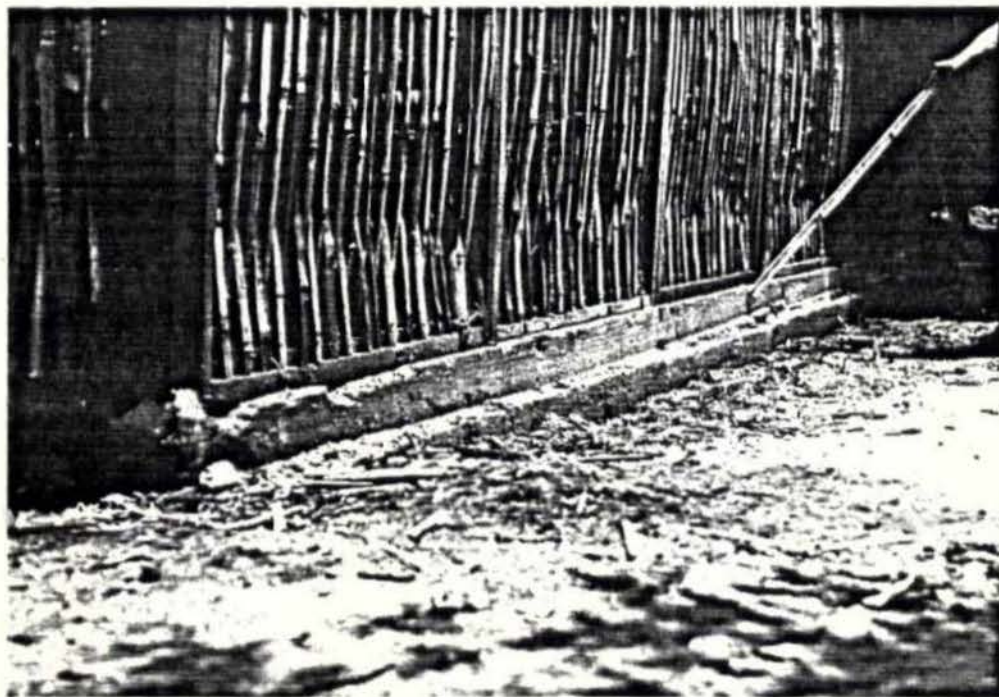
8. Montaje de módulos al sobrecimiento
